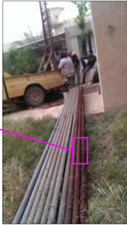
شكل (6-21) تآكل أنابيب رفع المياه من البئر إلى السطح بسبب ملوحة المياه العالية
