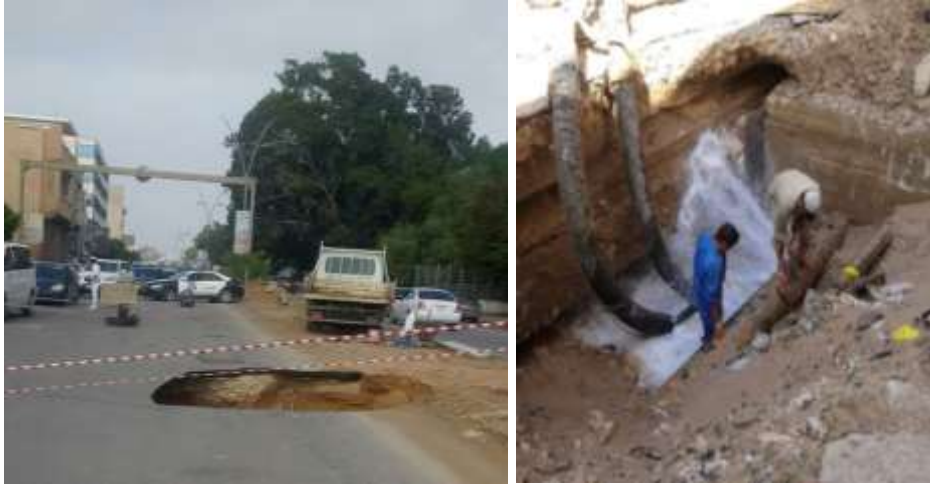
شكل (6-19) تآكل وتلف شبكات توزيع المياه في المدن وحدوث انهيارات بالطرق العامة
