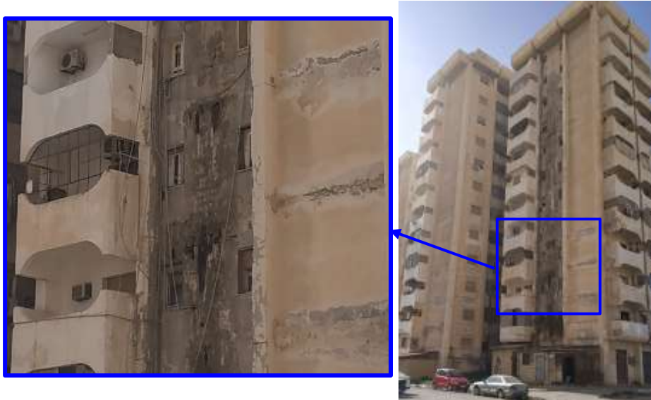
شكل (6-20) أضرار وتشققات في بعض المباني نتيجة لتسرب المياه من الشبكات المتآكلة بمدينة طرابلس
